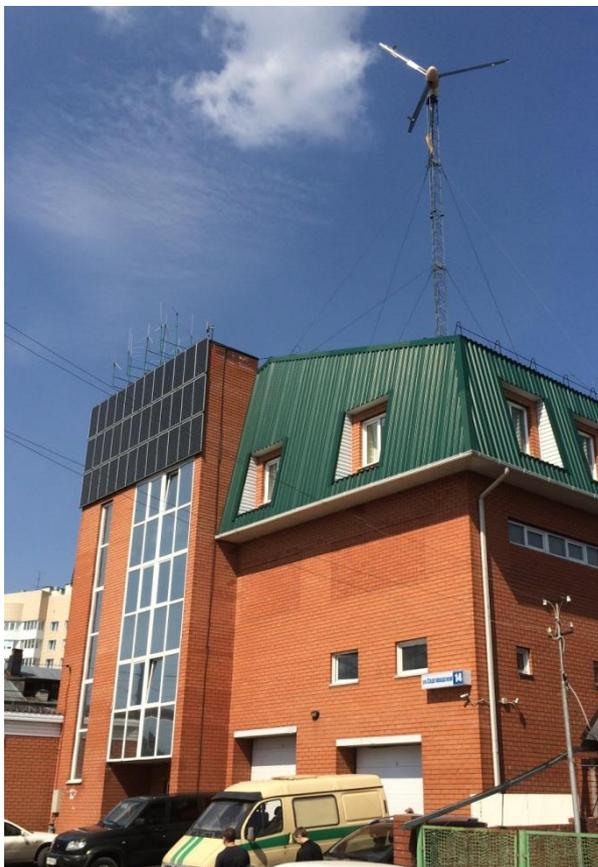
Рис. 3.6. Автономный дом «Апарт-отель» в г. Барнаул, Алтайский край. Используются ветрогенератор, солнечные панели, энергосберегающие технологии строительства и материалы. Автор фото: А.В.Стеценко.
