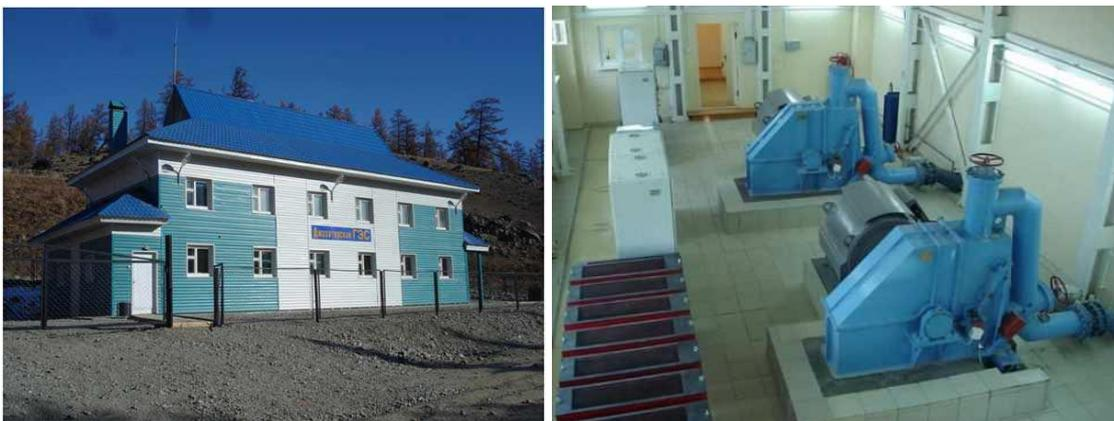
Рис. 3.4. Гидроэлектростанция с. Джазатор, установленная мощность 630 кВт. Фотографии предоставлены ООО «Солнечная Энергия+».
