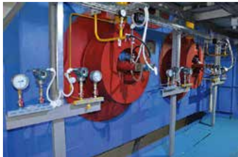
Новые высокоэффективные горелки ГМУ-40М
